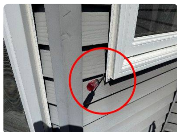
Ouverture de l'enveloppe sous la fenêtre
