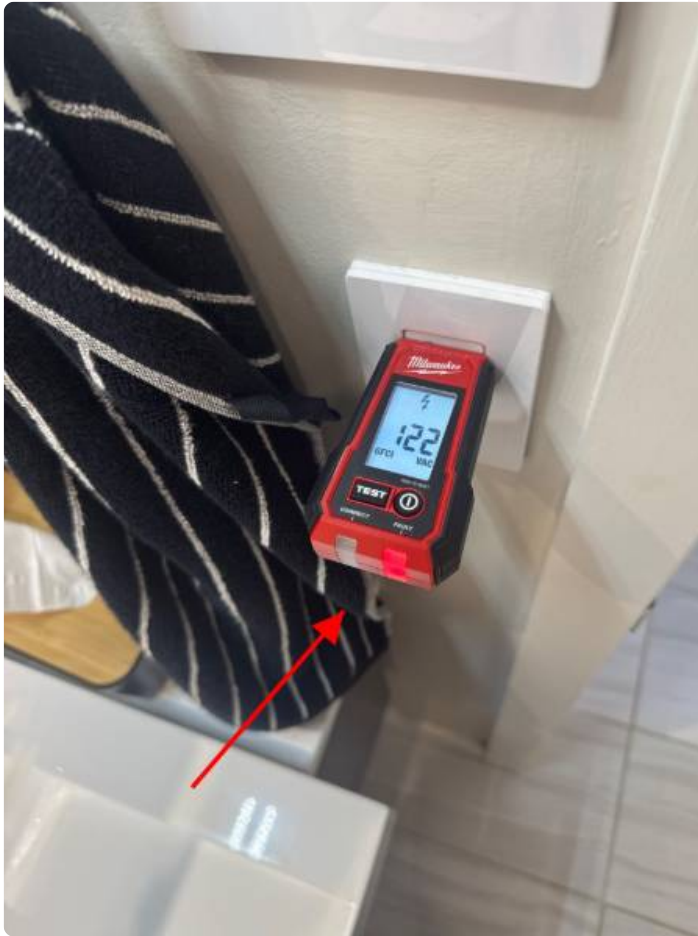
Prise de salle de bain du Rez-de-chaussé
