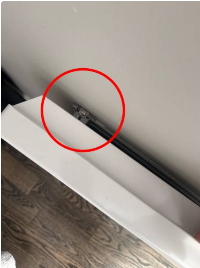
Mauvaise ancrage
