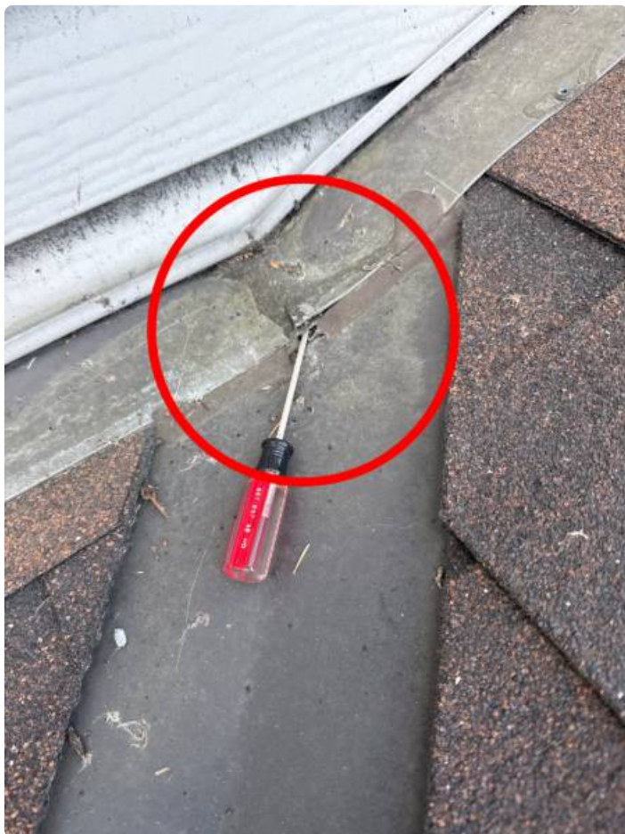
Solin de l'avant-toit en façade
