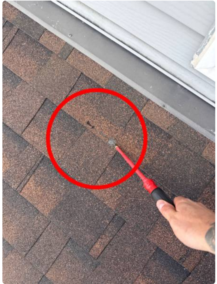
Bardeau d'asphalte sur l'avant-toit
