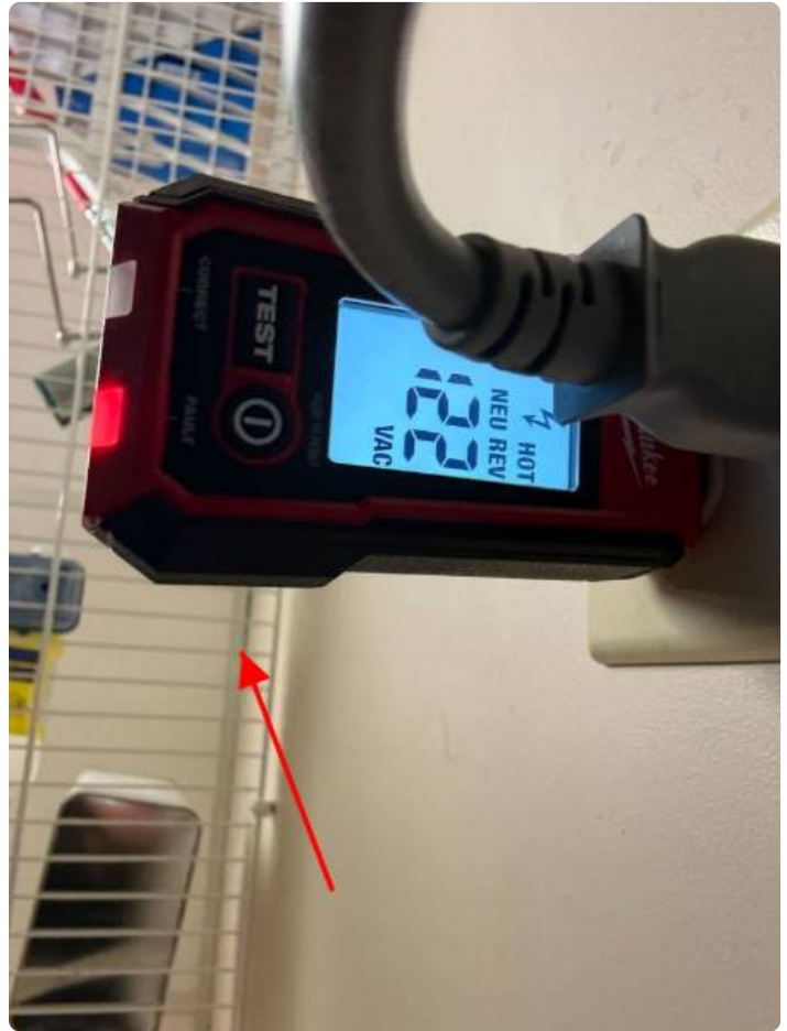
Prise de la salle de lavage près de l'évier
