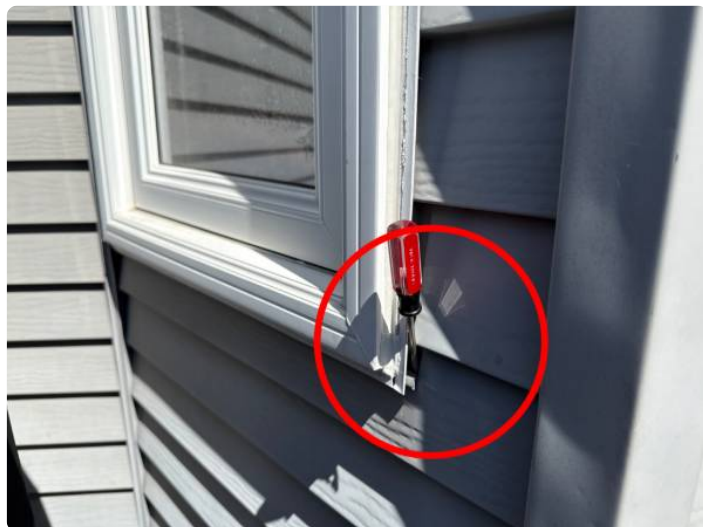
Ouverture de l'enveloppe sous la fenêtre
