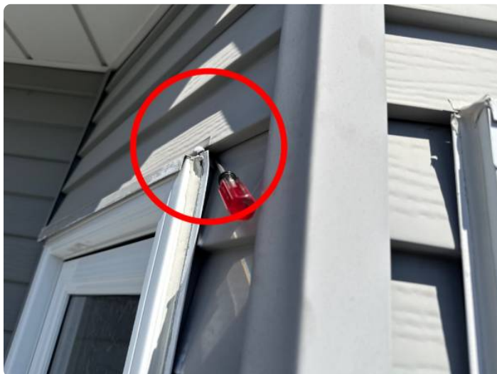
Ouverture de l'enveloppe sous la fenêtre
