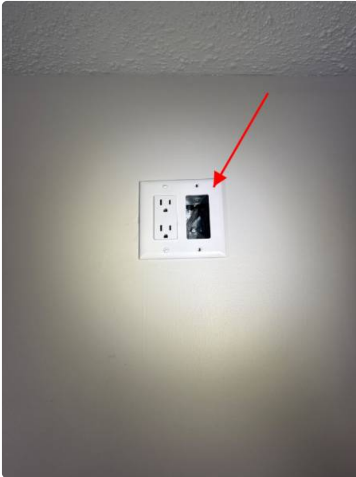
Ouverture de la plaque dans la chambre principale.
